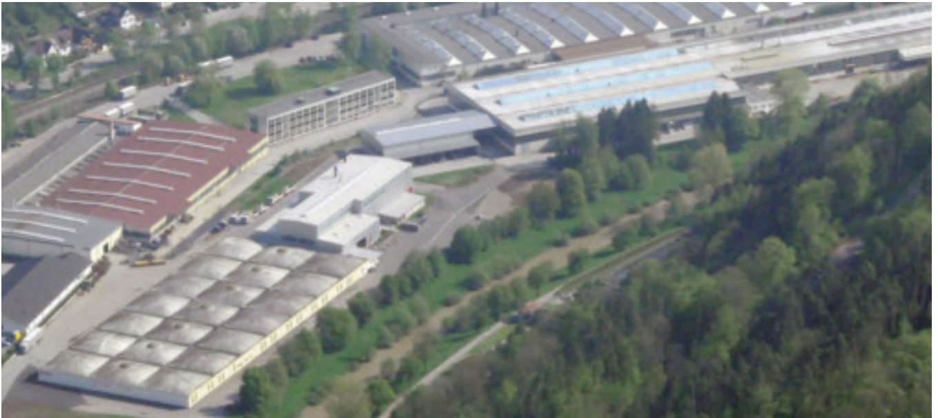
Lichtgitter - Usine Sulz
