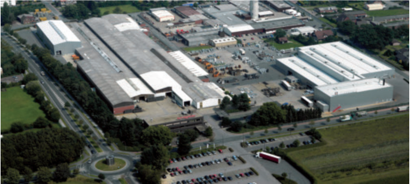
Lichtgitter - Usine Stadtlohn
