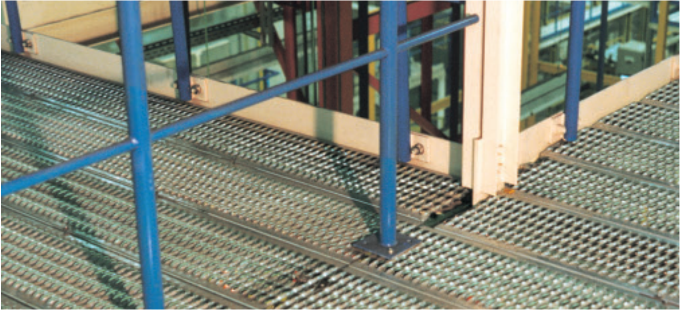
Plancher d'un hall de magasin intermédiaire
