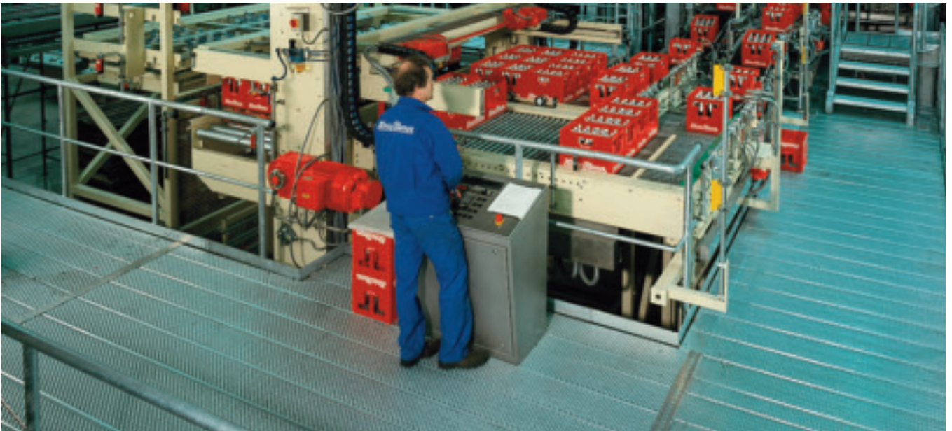
Échafaudage dans un installation de soutirage
