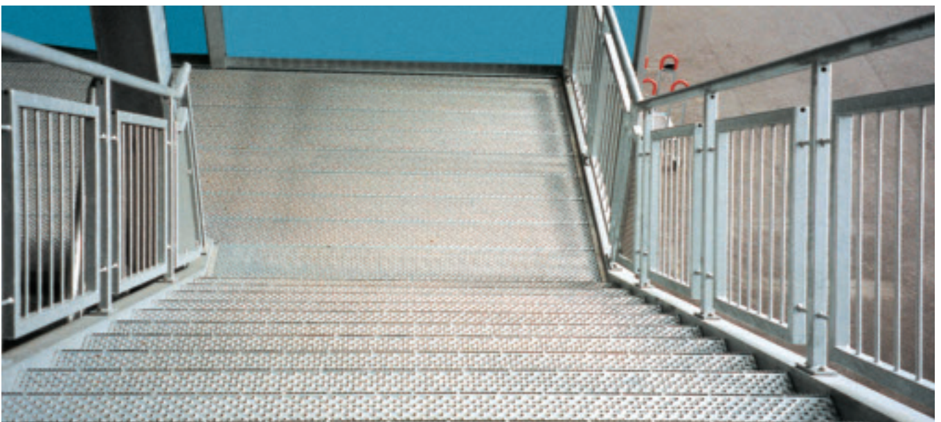
Escalier avec palier de repos
