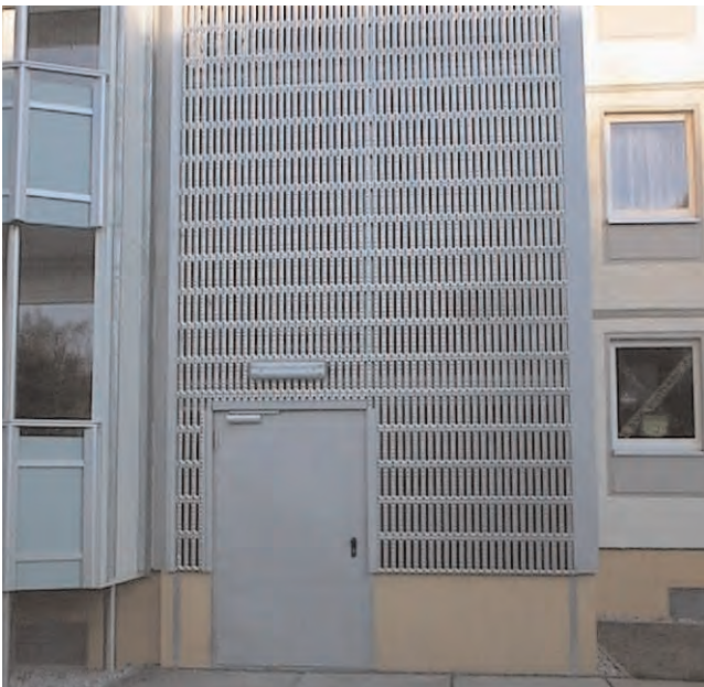
Installation sur façade
