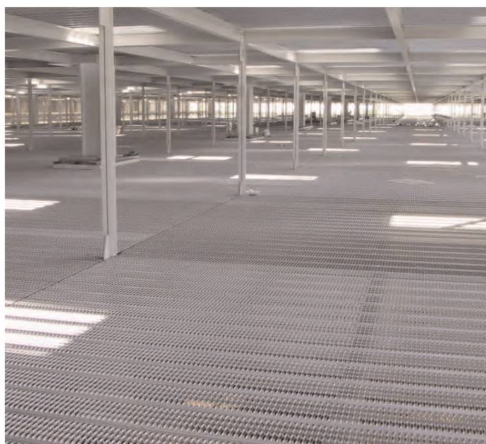
Plancher intermédiaire chez BMW Regensburg
