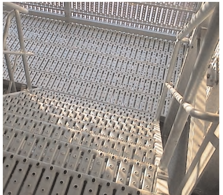
Installation pour un escalier
